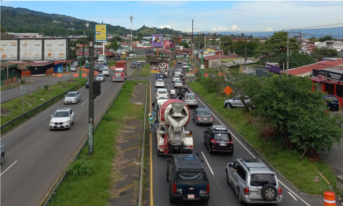
Vista de la Carretera de Circunvalación desde el puente peatonal de Hatillo 4. Se observa el área de construcción del puente que eliminará los semáforos en ese sector.
