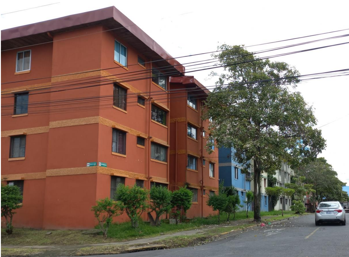
Conjunto habitacional de los Multifamiliares de Hatillo 5.
