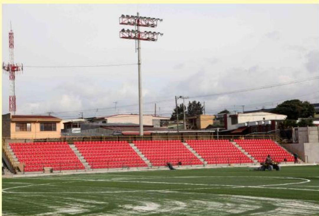
El Estadio Ernesto Rohrmoser ahora cuenta con modernas graderías, iluminación y cancha sintética.
