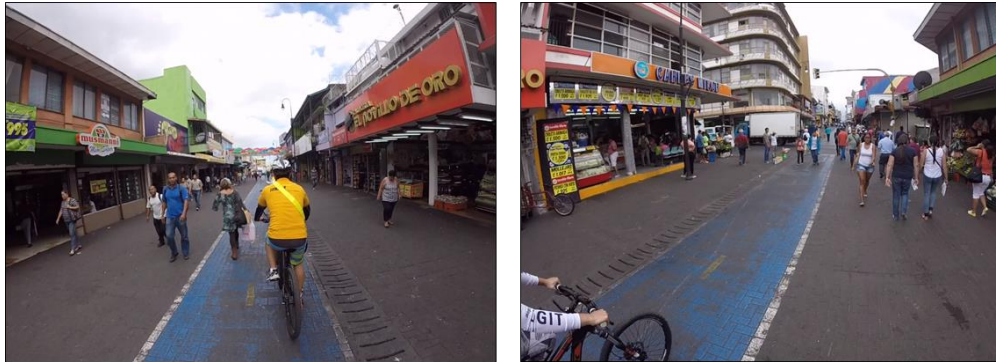
Figura 15. Decoloración de la ciclo vía, tramo entre Calles 4 y 12.
