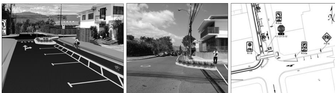
Figura 24. Fotomontaje de isla construida, intersección Ave 8 – Calle 41.
